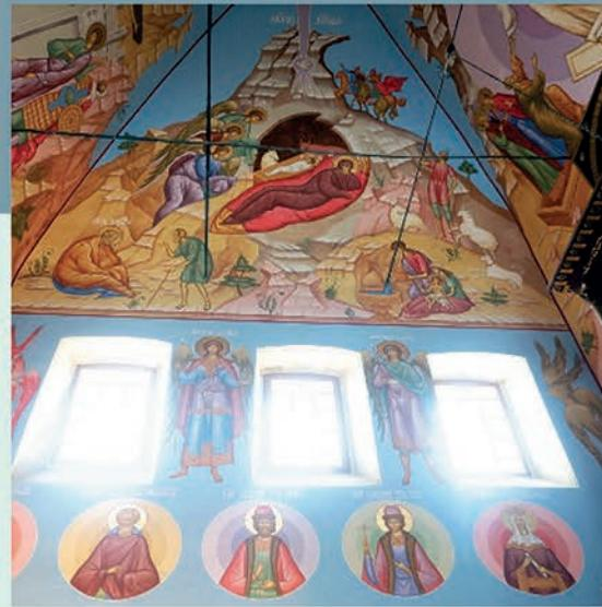
**Храм Николая Чудотворца в посёлке Кадый Костромской области.** Подготовка стен под силикатную роспись, Fassaden-Füllspachtel extrafein. Силикатная роспись: грунтовка Kieselit-Grundiermittel, силикатная краска Kieselit-Fassadenfarbe, силикатный лак Kieselit-Lasur, силикатные красители Kieselit Vollton- und Abtönfarben. 2016-2017 г.
