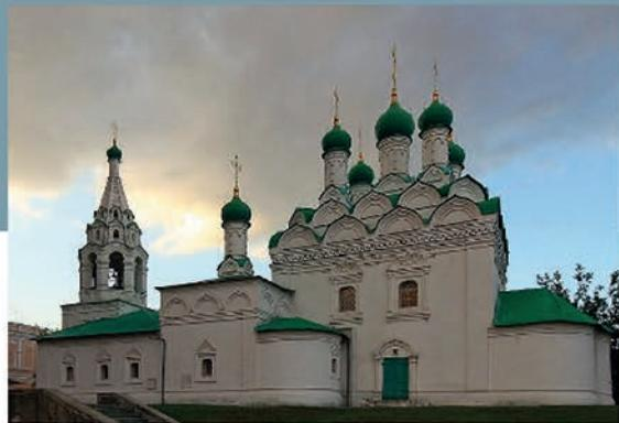
**Храм преподобного Симеона Столпника на Поварской.** г. Москва, ул. Поварская, д. 5. Подготовка стен: грунты на растворителях Grundierfarbe R и L-66 Tiefengrund. Силикатная роспись: силикатная грунтовка Kieselit-Grundiermittel, силикатная краска Kieselit-Fassadenfarbe, силикатный лак Kieselit-Lasur, силикатные красители Kieselit Voltton- und Abtönfarben. 2010 г.
