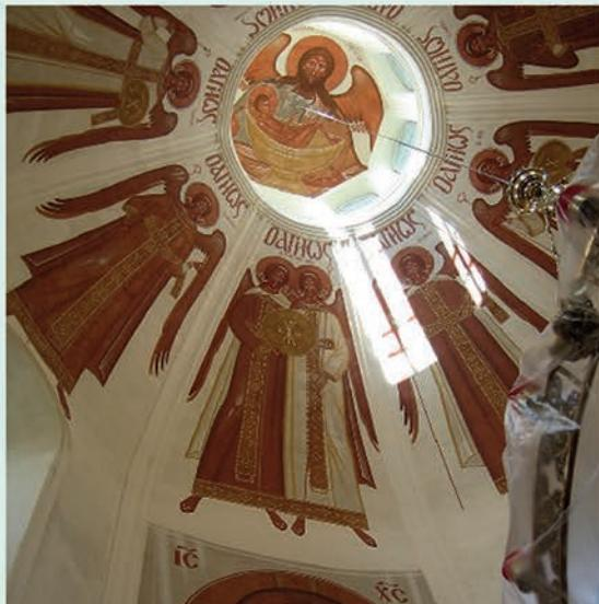
**Храм Рождества Иоанна Предтечи.** Тверская обл., Осташковский район, Ширков погост. Подготовка стен под силикатную роспись, силикатная роспись: силикатная грунтовка Kieselit-Grundiermittel, силикатная краска Kieselit-Fassadenfarbe, силикатный лак Kieselit-Lasur, силикатные красители серии Kieselit. 2010 г.
