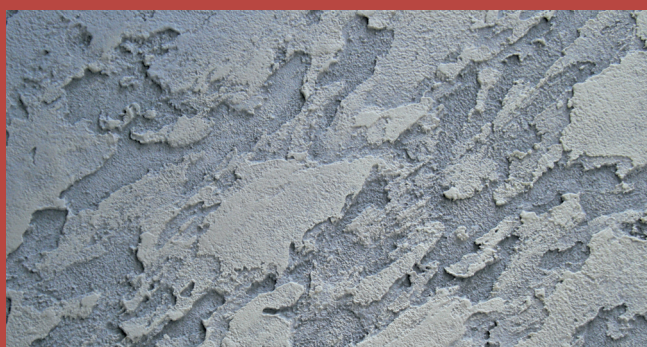
Технология нанесения: Штукатурка Modellierputz; краска Seidenlatex 3 оттенка
